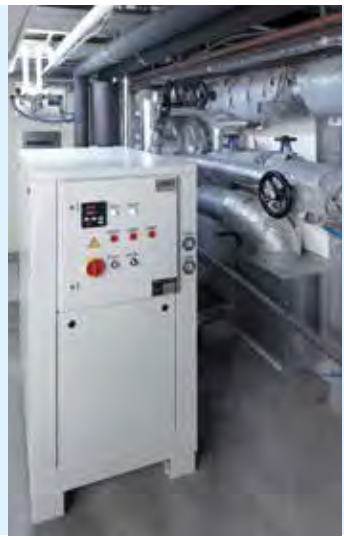
Prozessmodul und Versorgungsmodul können getrennt voneinander aufgestellt werden
