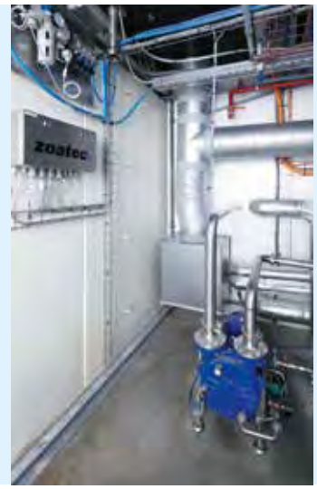
Prozessmodul und Versorgungsmodul können getrennt voneinander aufgestellt werden
